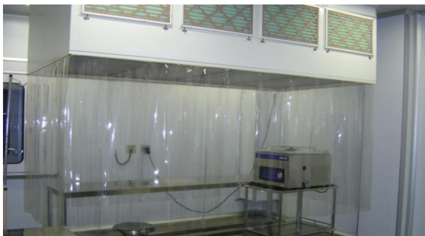
Figura 3: Sala de processamento classificada (100 partículas/ m^3 ar: classe 100/ISO 5; Filtros HEPA 99,9 %)
