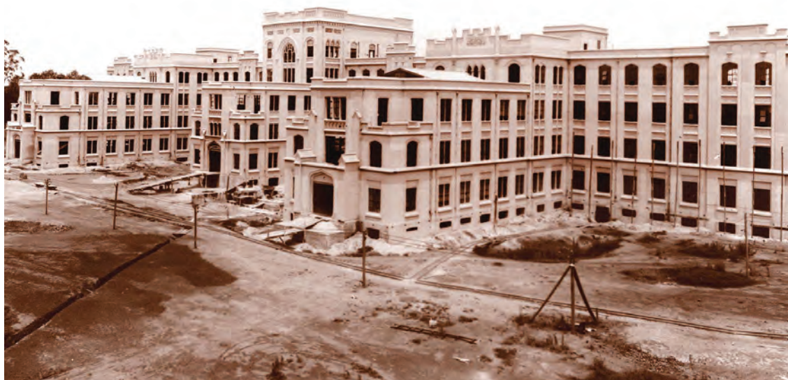
Obras da Faculdade de Medicina. Construction of Medical School.
