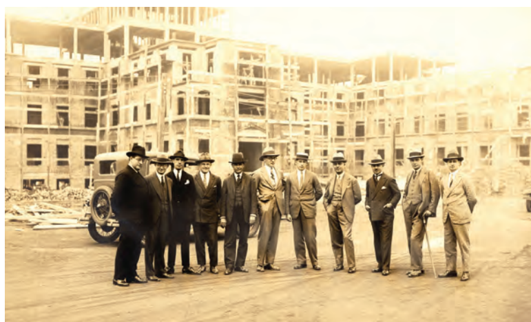
Professores e arquitetos em frente à obra do novo prédio da Faculdade. Professors and architects in front of the new Faculty building construction area.
